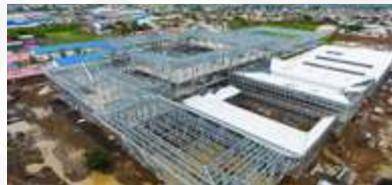
*HOSPITAL DE MANTA 1500 TON de estructura galvanizada*
