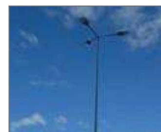
Postes troncocónicos de 12m de altura con brazo triple, galvanizado y pintura electrostática. (PROYECTO AMBATO AV. LUIS ANIBAL GRANJA).
