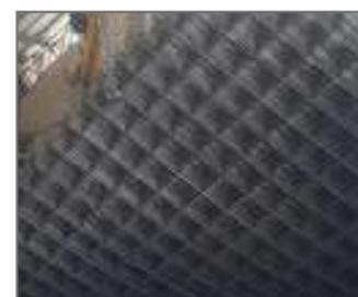
Mallas electrosoldadas para reforzamiento de hormigón, listas para ser usadas facilitando el proceso constructivo, optimizando los diseños estructurales y recursos de obra.
