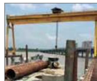
Construcción y montaje de pórticos grúa de 40 y 50 toneladas.
