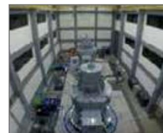
Vista de la CH SAYMIRIN V con 2 turbinas Pelton de 3.8 MW cada una, fabricadas por DELTA.
