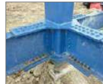
Fabricación y montaje de estructuras metálicas empernada 280ton.
