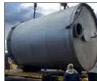
Construcción y montaje de tanque con capacidad de 50 toneladas en acero inoxidable AISI 304, para almacenamiento de aceite vegetal.
